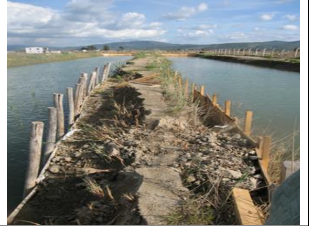
Şekil 6.9. Toprak havuz işletmelerinde karşılaşılabilecek mekanizasyon orijinli risk kaynakları
